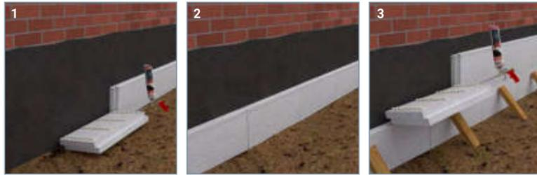
1. Dämmplattenkleber streifenweise im Abstand von ca. 25 bis 30 cm aufbringen.
