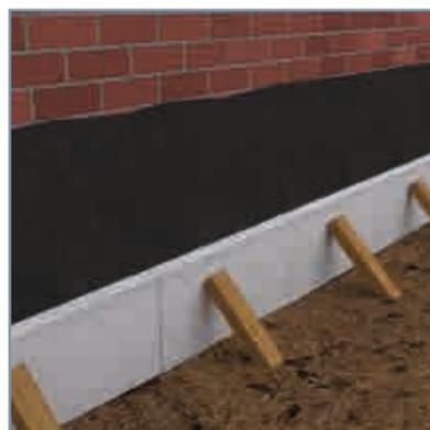
3. Unterste Reihe der Dämmplatten ausrichten und abstützen.
