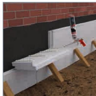
4. Bereits nach wenigen Minuten kann die zweite Reihe aufgesetzt werden.
