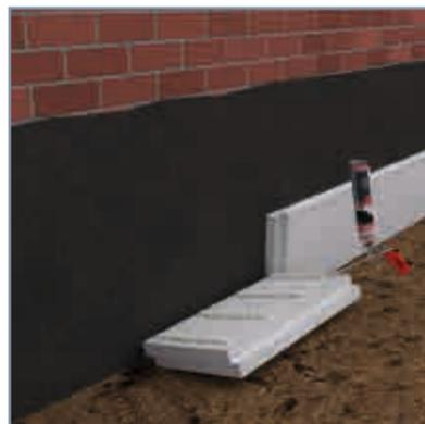
1. Dämmplattenkleber streifenweise im Abstand von ca. 25 bis 30 cm aufbringen.
