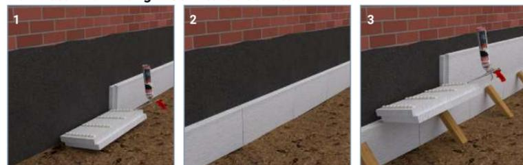
1. Dämmplattenkleber streifenweise im Abstand von ca. 25 bis 30 cm aufbringen.
