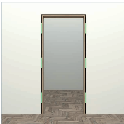
3. Nach der Aushärtung entspreizen und überschüssigen PU-Schaum abschneiden.
