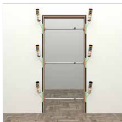
2. Ausschäumen mit zweikomponentigem PU-Schaum.
